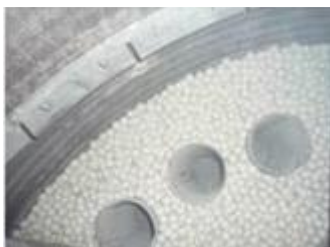
Рис. Загрузка распределительных фарфоровых шаров в верхней части реактора.
